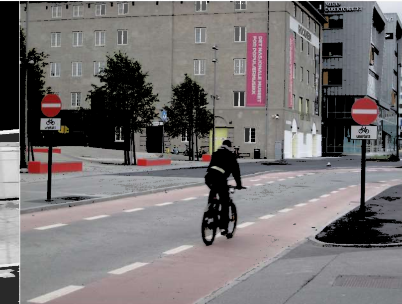
Sykkelfelt i kjørebanelen. Foto: Statens vegvesen v/ Lars Christensen
